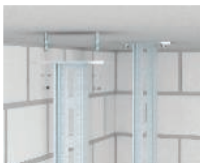
Riputuskonstruktsioon betoonile Laia sildega kaablirennile sobiv riputuskonstruktsioon betoonis IS 8 profiili ja poltankrutega.
