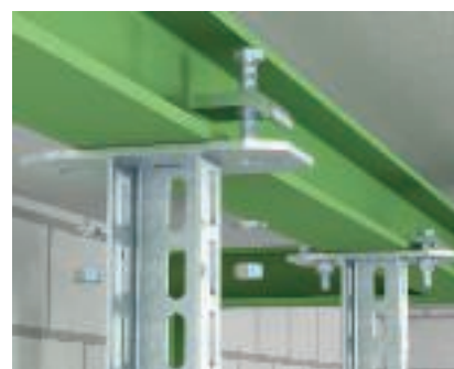
Vahetu terasklammerdus U-ripitusprofiili vahetu terasklammerdus nurkklemmi KWS abil. Trass kulgeb piki teraskandurit.
