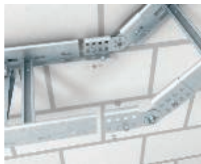
Kaabliredelite vertikaalne nurgäühendus Vertikaalse nurgäühenduse loomine liigendühendustega LGVG.
