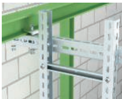
Vertikaalredeli paigaldamine terasele Raske vertikaalredeli SLM 50 paigaldamine teraskonstruktsioonile U-profilist kanduri abil.
