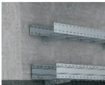
Kasutamine: seinamontaaž Laia sildega kaablirennide vahetu seinamontaaž
