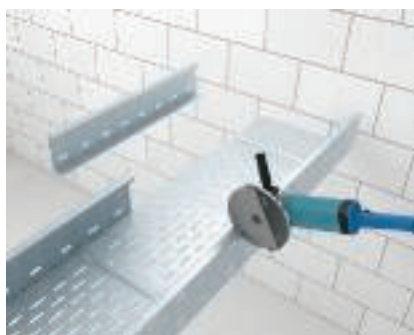
T-hargnemiskoha loomine nurgadetaili abil Külgtalade väljalõikamine laia sildega kaablirennist.
