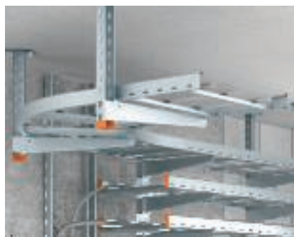
Valmismontaaž Pilt: valmis kaabliredelipaigaldis.
