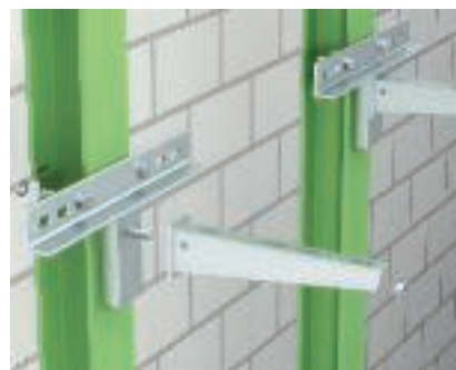
Klamberkinnitus vertikaalsetele teraskanduritele Adapterplaadi KA-AW paigaldus vertikaalsele teraskandurile nurkklabrite või pingutussõrgade abil. Adapterplaadile kinnitatakse seinakandurid AW kuuskantpoltide SKS 12x40 GF abil.
