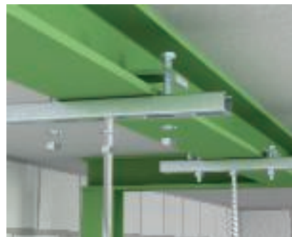
C-profiiliini terasklamber C-profiili (tüüp CPS 4 G või CPS 5 G) kinnitamine terastalale nurkklabri (tüüp KWS) abil.
