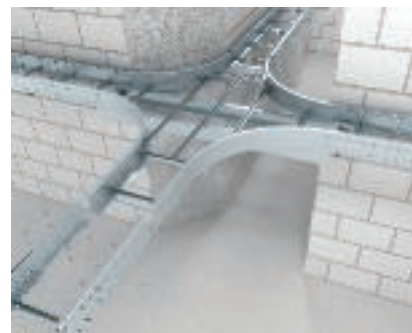
Ristmiku paigaldus Ristmik koos tugevdatud kaabliredeliga. Ristmik ühendatakse välisühenduste abil tugevdatud kaabliredeliga.
