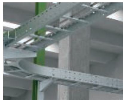
Kasutamine: terasklambrid Tugevdatud süsteemi monteerimine teraskanduritele kinnitatuna.
