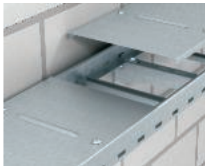
Kaane monteerimine Kaane paigaldamine ja kinnitamine kaabliredelile pöördriiviga DRL.
