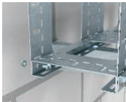
Põhjaprofiili paigaldus Põhjaprofiili paigaldamine BKK-süsteemi.
