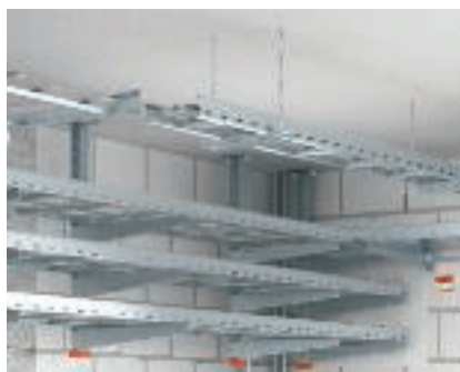
Kasutamine: riputusprofiili ja keelmeesvardaga riputamine Kaabliredelite paigaldamise näide U-profiilidest ja keelmeesvardast riputusprofiili abil.
