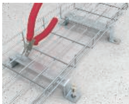
Korvrennide tõstmine Korvrennide põhja tõstmine distantsklambriga (tüüp DBLG 20/...) Korvrenni kruvivaba kinnitamine distantsklambrile klemmplaatide abil.
