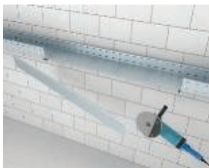
T-hargnemiskoha loomine nurgadetaili abil Külgtala väljalõikamine läbivast laia sildega kaablirennist.
