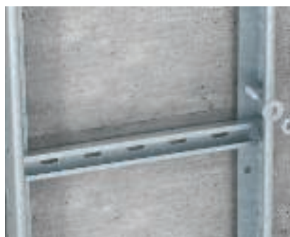
Vahetu seinale monteerimine Vertikaalredeli LG ja SSL vahetu kinnitamine poltankrute abil seinale.
