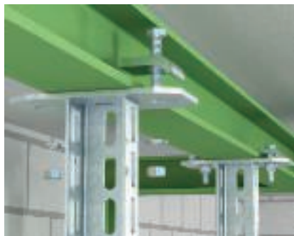
Kasutamine horisontaalsel teraskanduril Klamberkinnitused klambernurkade ja pingutussõrgade abil horisontaalsetele teraskanduritele.
