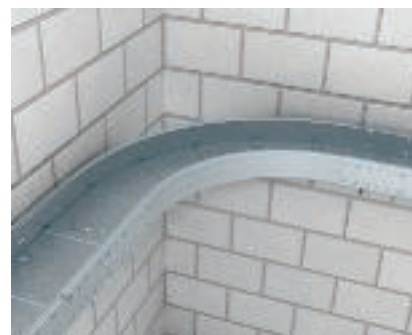
Põlve montaaž 90° Põlv koos tugevdatud kaablirennidega. Põlv ühendatakse välisühenduste ja ühendusplaadi abil tugevdatud kaablirenniga.
