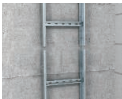
Vertikaalsete redelite pikiühendamine Vertikaalredelite LG und SSL 60 liitekoht ühendusega LVG.
